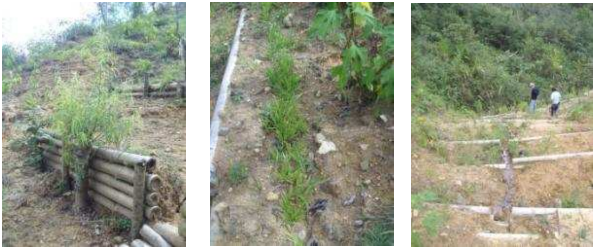
Fotos 13.b – Trinchos en guadua realizados por la Fundaciòn Rio Las Piedras. Utilizo de estacas vivas como palos verticales (izquierda); herbaceas sembradas en forma de semillas en la terraza de un trincho (centro); terrazas de trinchos y canal central para el manejo de agua (derecha) (fotos: C. Crocetti)
