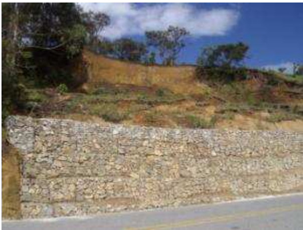
Fotos 13.a – Deslizamientos arreglados solo con gaviones en la zona de Popayan (fotos: C. Crocetti)
