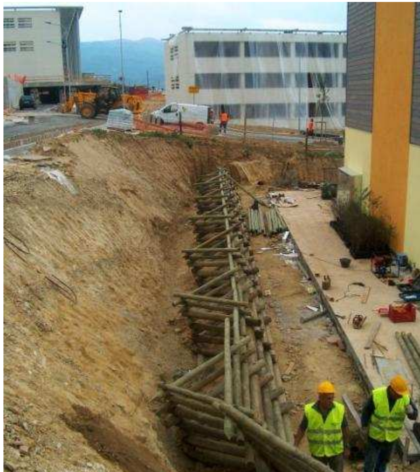
Foto 7.2.a – Estructura de madera del entramado latino (C. Crocetti)
